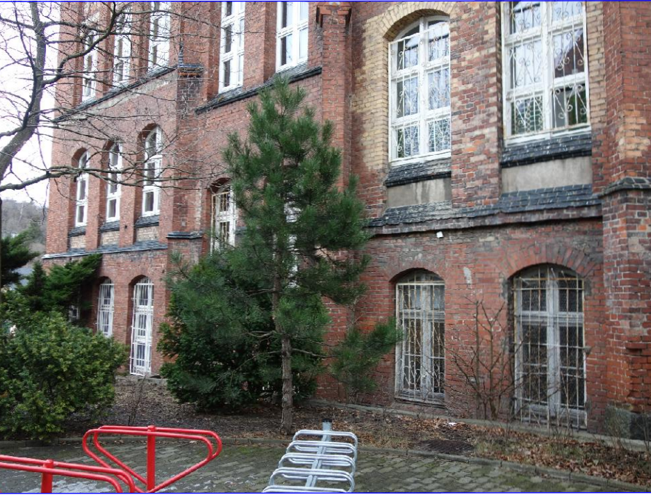
Przemurowania wtórne cegłą żółtą
