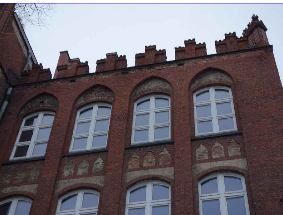
Ubytki tynku w blendach wypłukane fugi pod gzymsem
