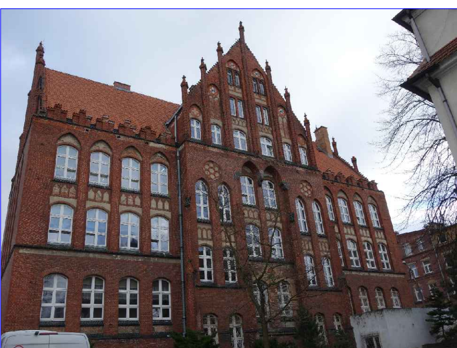
Ściana zachodnia - elewacja zabrudzona orynnowanie skorodowane
